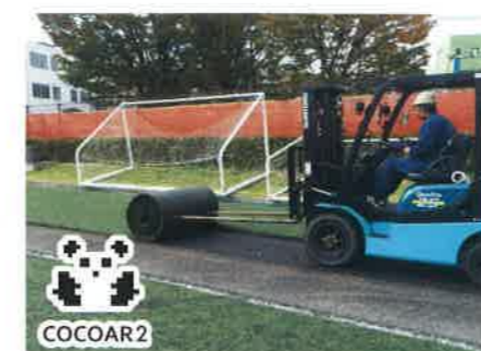
人工芝をリサイクル可能にする為、巻き取り・検品を現地にて同時に行い、廃棄物を出さないシステム。
